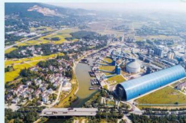
小浦码头配置的熟料储存、装船输送系统
