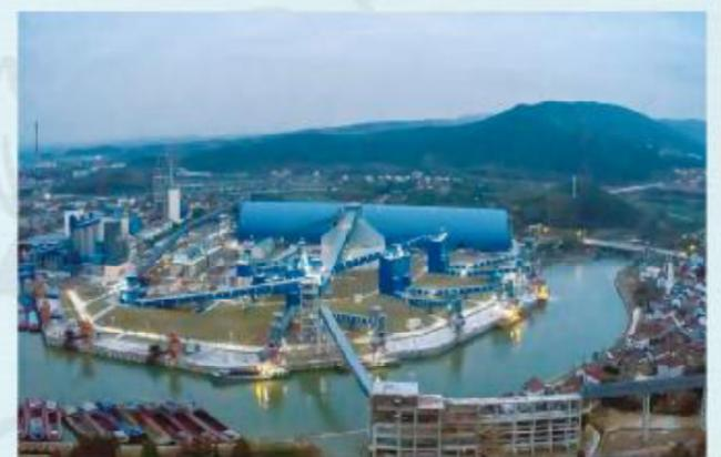
小浦码头配置的熟料储存、装船输送系统
